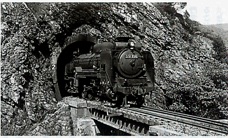
6号トンネル入口のアーチを構成する迫石（せりいし）。7重になっているのは、全国でもここだけではないかという見解も
