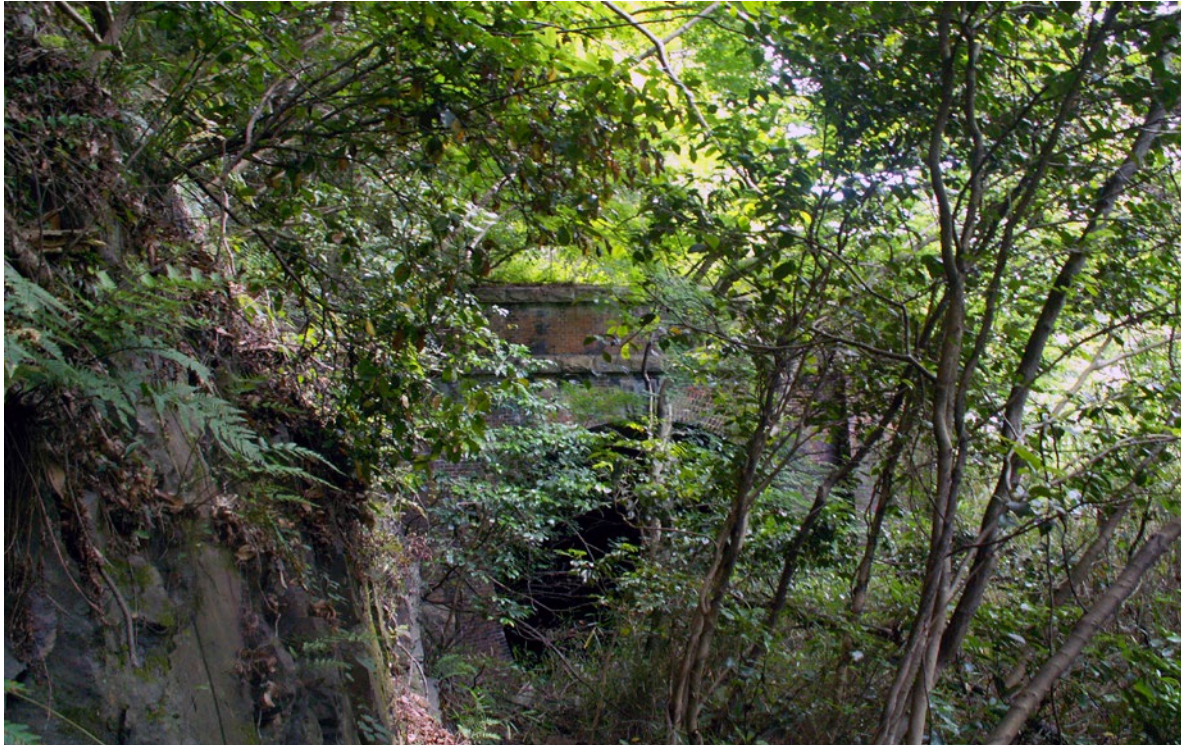
写真1 発見当時の3号トンネル
