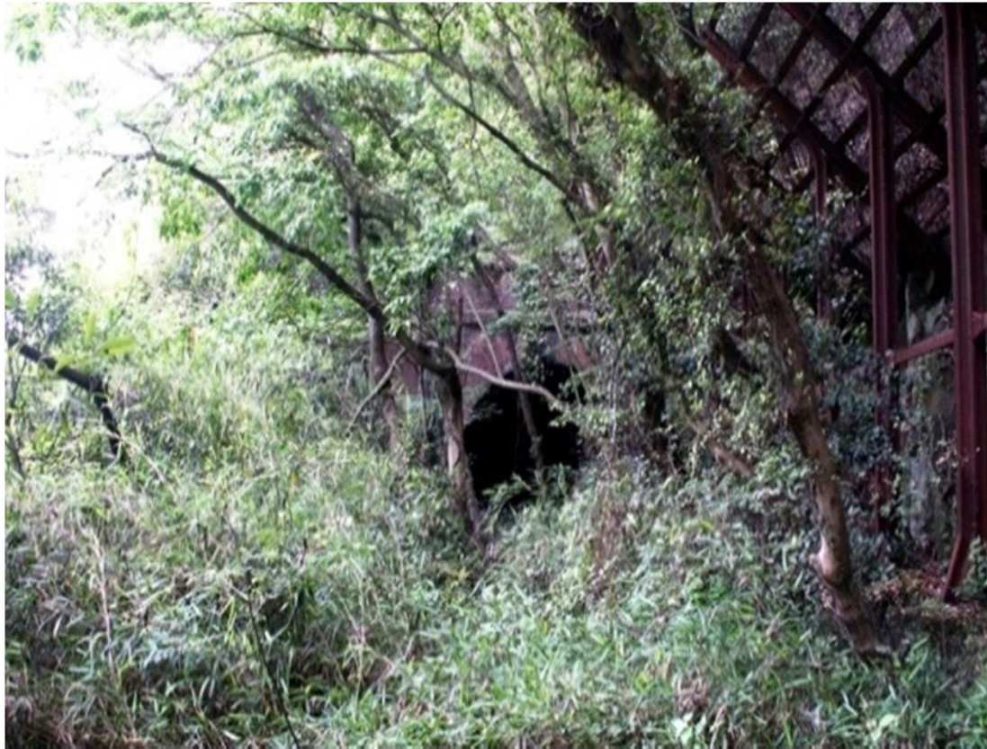
多治見口と落石防護柵
