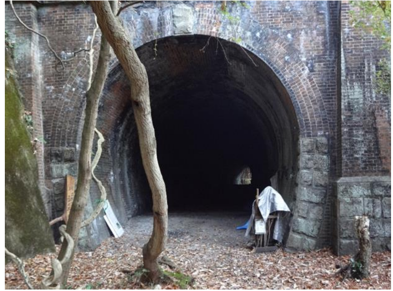
現在のトンネル群
