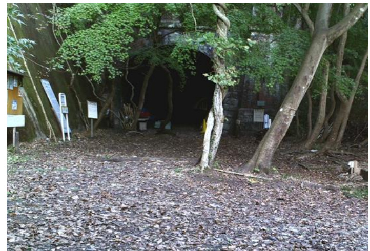
AG1 (トンネル出入り口付近)
