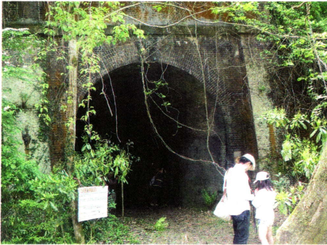
廃線跡のトンネルを散策する保存再生委員 員。愛岐トンネル群保存再生委員会提供
