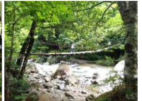
吊り橋もあります。
